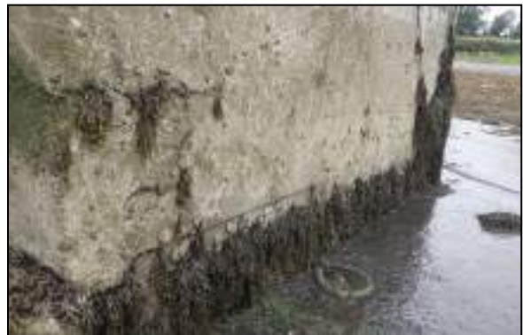
Fig. 218. General habitat: Concrete pier.
