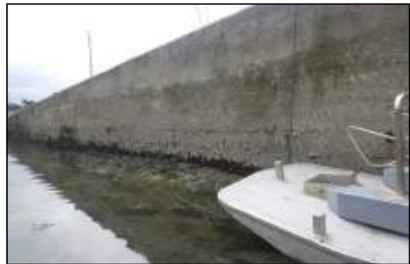
Fig. 209. General habitat: Concrete pier.
