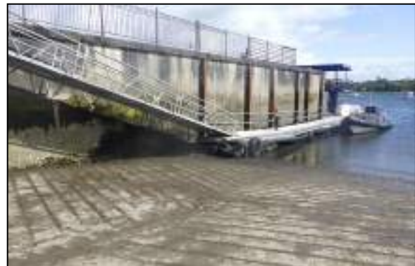
Fig. 344. General habitat: Concrete pier.
